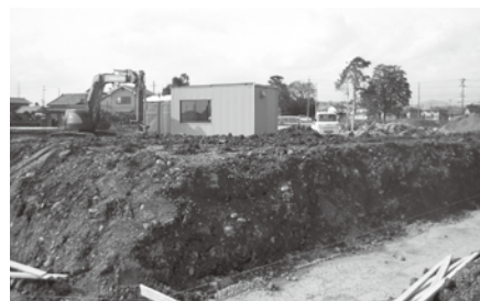
造成工事 現場写真
