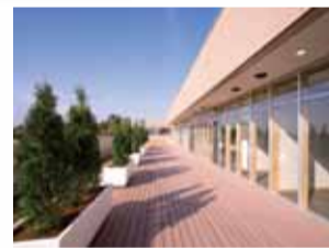
2Fウッドデッキ
