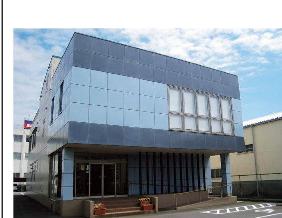
岳南排水路管理組合庁舎
