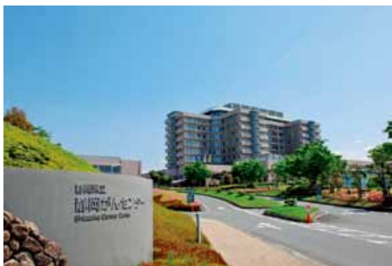
入口からの建物外観
