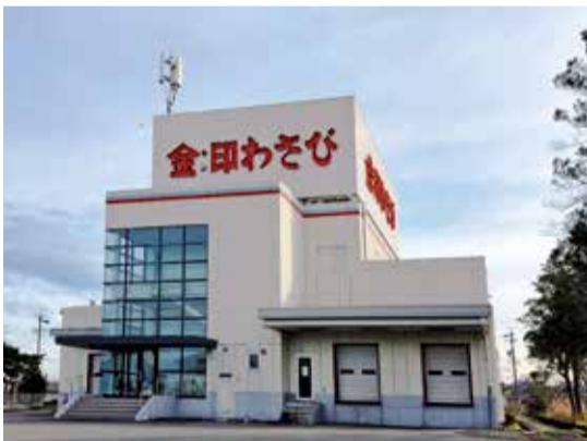
金印わさび(株)静岡工場
